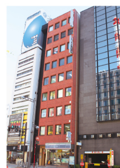
東京銀座本社ビル
