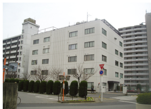
東新小山ビル
