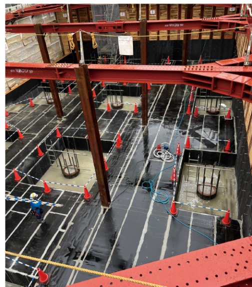
新 築 国立病院 地下外壁 先やり （EVA系シート防水 SA-321）
