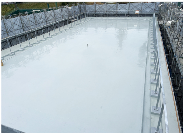
新築 プロ野球球団独身寮 屋上 (ウレタンゴム系塗膜防水 DSX-1)
