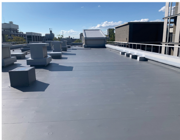
新 築 某大学 屋上（塩化ビニル樹脂系シート防水 SI-M2）
