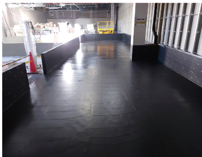
新築 スーパーマーケット 厨房 (改質アスファルトシート防水 E-30)
