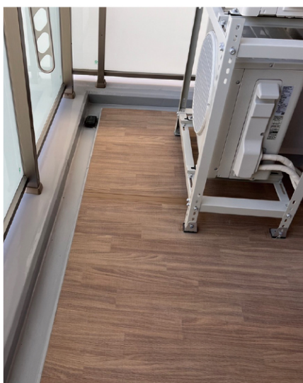
新築 集合住宅 バルコニー (ウレタンゴム系塗膜防水 DSM-200)
