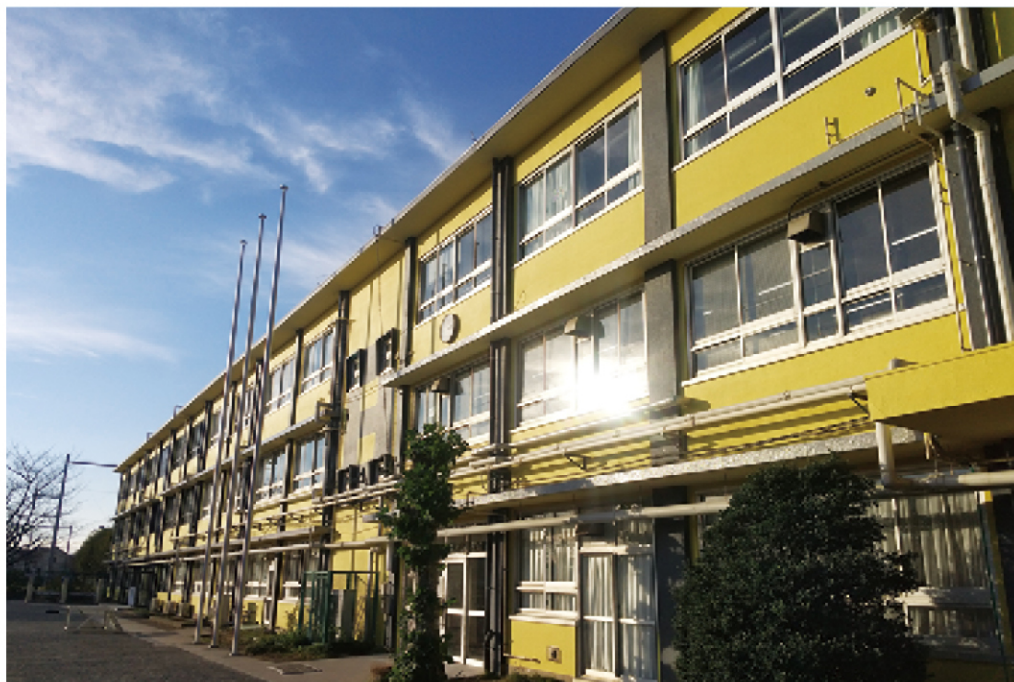
改修 教育施設 外壁（水性弾性塗装）
