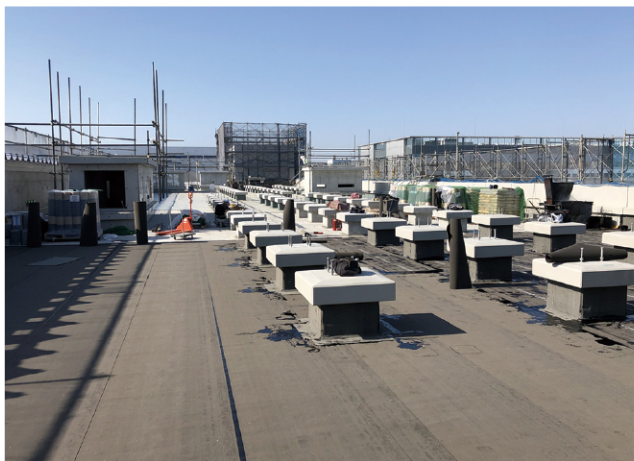
新築 電機メーカー工場 屋上 (アスファルト防水 FPI-1)
