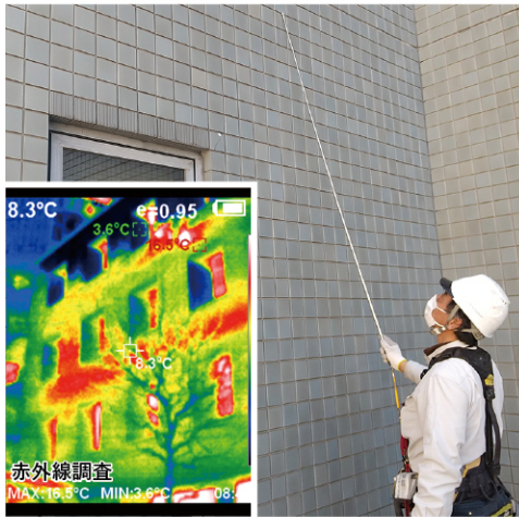
改修 事務所ビル 建物診断／外壁タイル劣化調査
