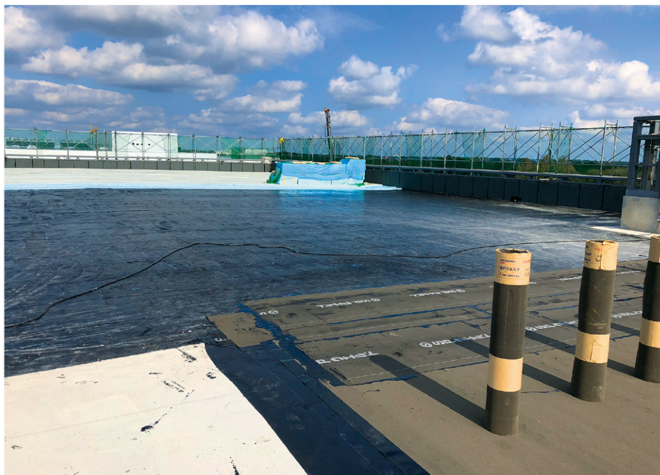
新 築 某新市場 屋上（アスファルト防水 FPI-1）
