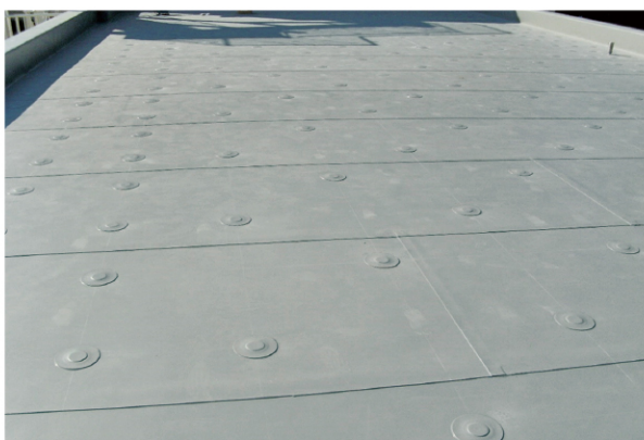
改 修 某発電施設 屋上 (OMベストプルーフシャネツ OSN-20M)
