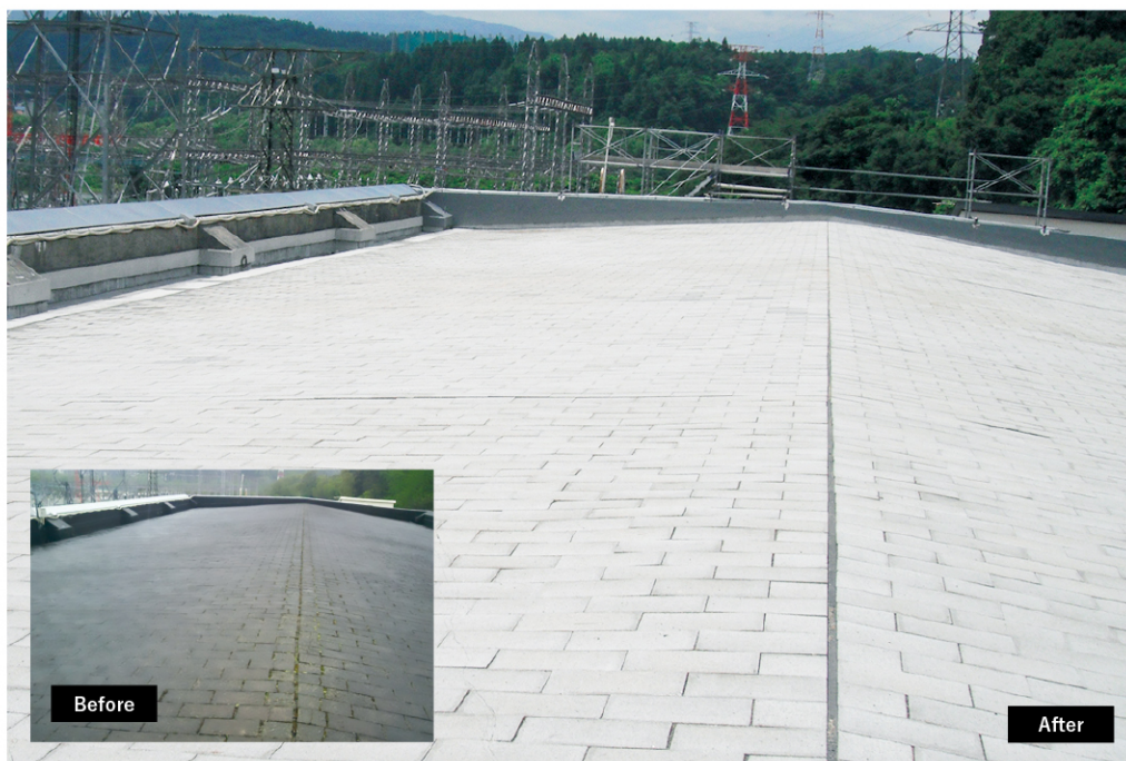
改修 某発電施設 屋上（特OA-1[改修] / OMルーフブロック新設）
