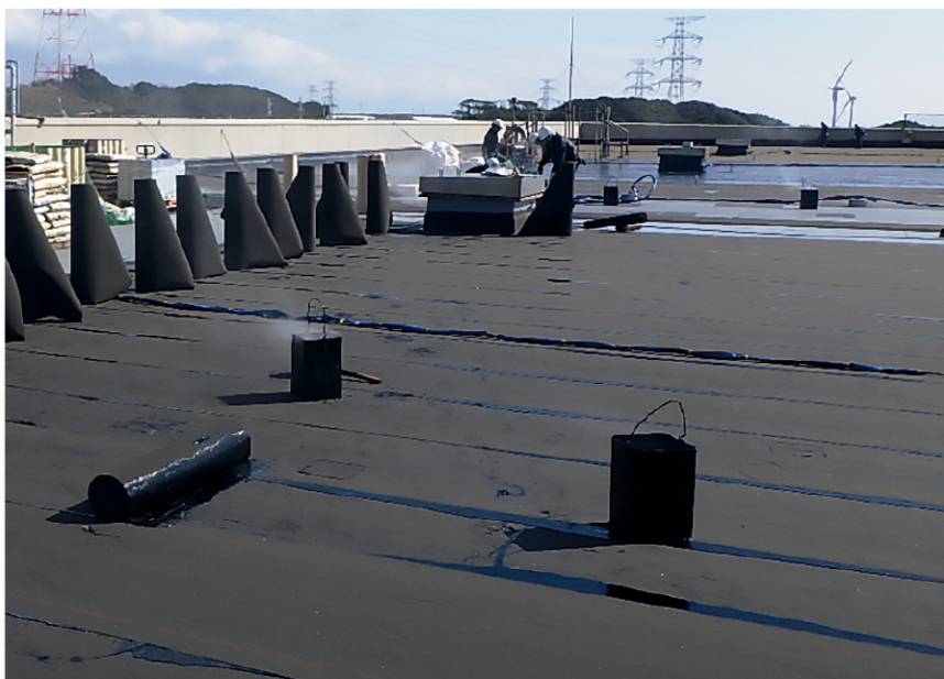
新 築 某発電施設 屋上（特 OA-1）
