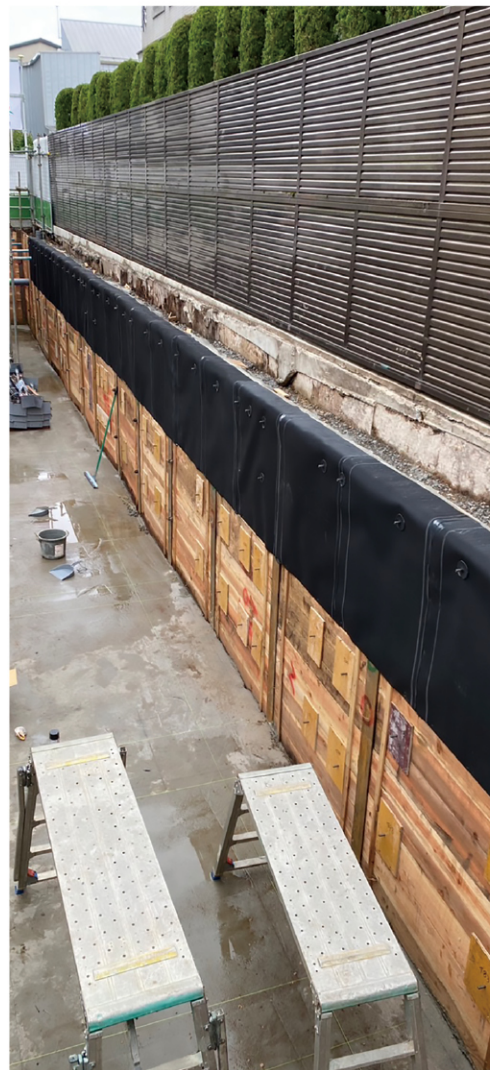
新築 集合住宅埋戻外壁 (EVA系シート防水 SA-321)
