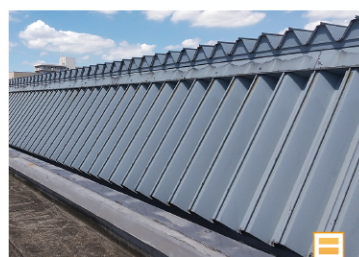
● 板橋／体育施設
