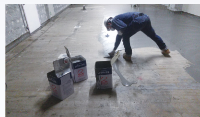
● 丸の内／店舗 リニューアル工事
