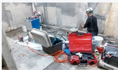
● 池袋／商業施設地下 止水工事
