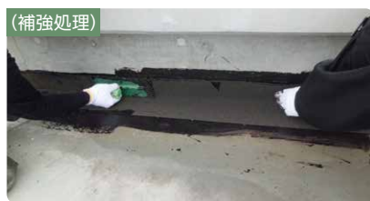
(補強処理) ハルレコート/ハルレシート200張付け
