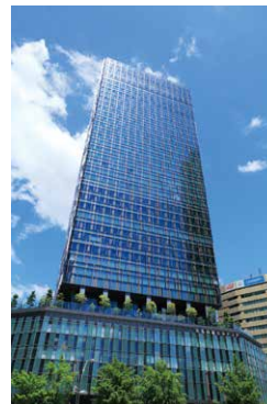
大名古屋ビルヂング
